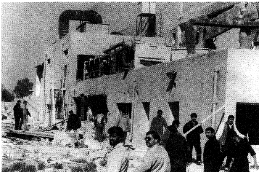
Irakezen ruimen puin bij de vermeende kernwapenfabriek in Zafaraniyah die op 17 januari door Amerikaanse kruisraketten werd getroffen.
