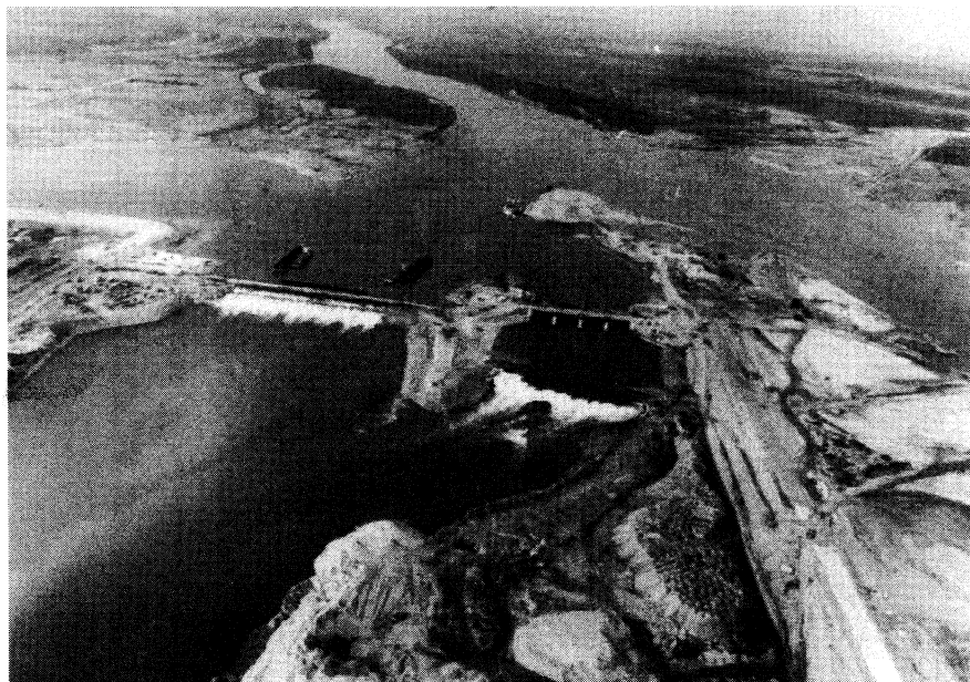
Luchtopname van de Gabčíkovo-Nagymaros-dam op 28 januari 1993.
